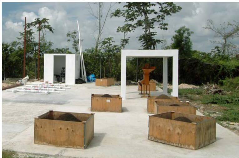
Fig. 3.4.- Compostas piloto en la planta de tratamiento de aguas residuales “Centenario”.
