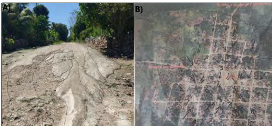
Figura. 28 A) Erosión de camino B) dirección de escurrimientos. Fuente: trabajo de campo, 2021.
