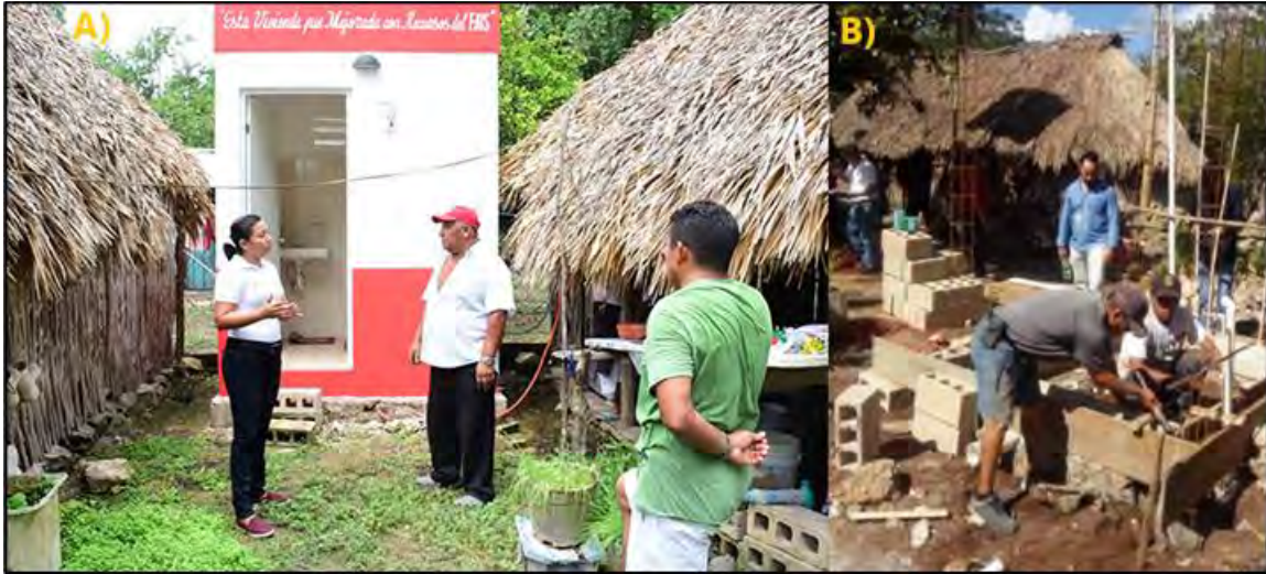
Figura. 41 A) Entrega de baño de concreto B) construcción de “baños dignos”. Fuente: Fotografías donadas por habitantes locales.
