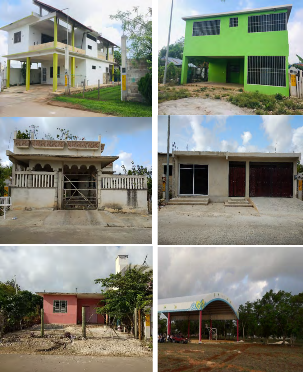
Figura 10. Trama y Alzado. Vivienda consolidada construidas con materiales permanentes
