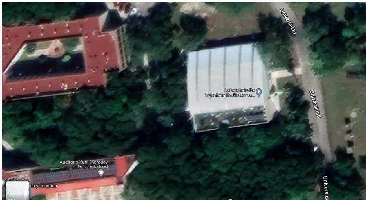
Figura 4.2: Ubicación del laboratorio de ingenierías de la UAEQROO.
