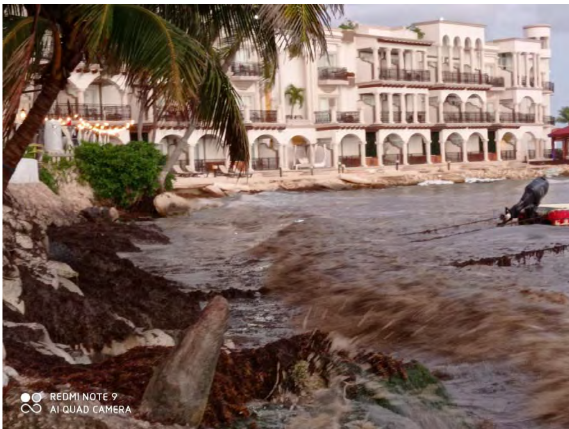
Figura 3.24 Inaccesibilidad a la playa recodo entre porto real y calle 16, agosto 2021
