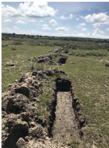
Imagen 14. Tinajas ciegas para captación de agua
