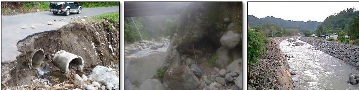
**Nota:** De izquierda a derecha, la imagen 1 muestra la carretera que conduce a la comunidad de Alto Quiel y la obstrucción de las alcantarillas por material rocoso y algunos escombros. La imagen 2 muestra socavación de uno de los puentes que comunica a la comunidad de Bajo Mono con otros centros poblados cercanos. La imagen 3 presenta el muro de contención construido en las riberas del río Caldera, frente a las instalaciones de la Feria de las Flores y el Café.
